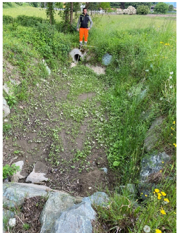
Foto 1A.3 - 1A.4 – Tratto 1A: Vista vasca di sedimentazione a valle S.P. 69 (uscita Ø 400 mm)
