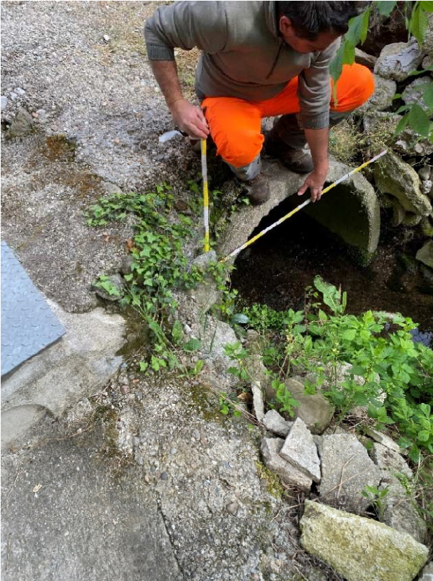
Foto 1D.1 – 1D.2 – Tratto 1D: Vista imbocco (a dx) e uscita (a sx) sottopasso a valle Via Madonnina (Ø 1000 mm)
