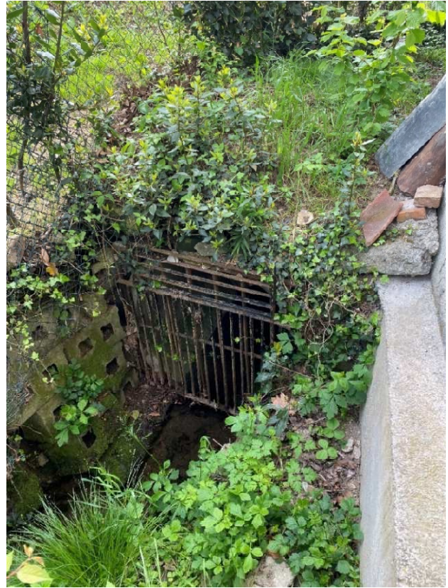
Foto 1D.1 – 1D.2 – Tratto 1D: Vista imbocco (a dx) e uscita (a sx) sottopasso a valle Via Madonnina (Ø 1000 mm)
