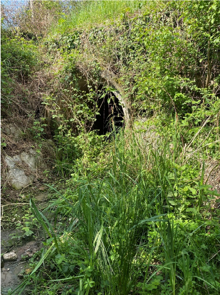
Foto 3.3 – 3.4 – Tratto 3: Vista tubi sottopasso Via Tregiorgio ( \varnothing 1500 mm e \varnothing 600 mm)
