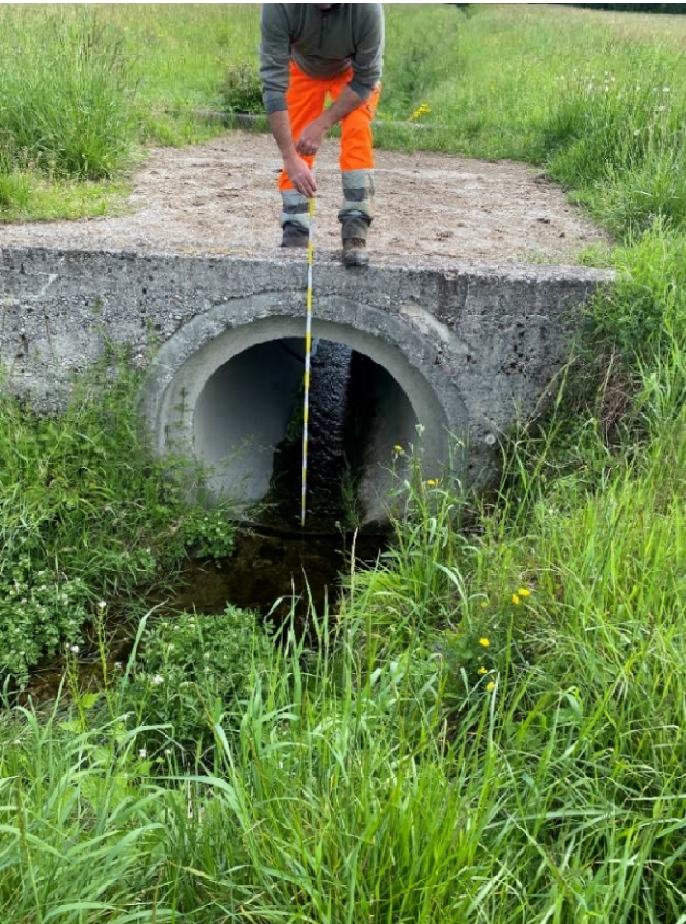
Foto 1.9 – 1.10 – Tratto 1: Vista attraversamento tra Via Pradonici e confluenza in T. Bevera (Ø 1000 mm)
