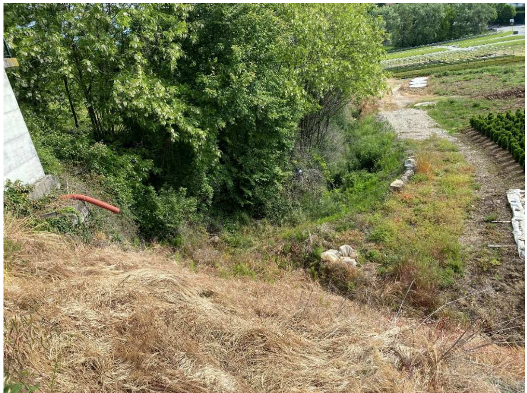
Foto 5.3 – 5.4 – Tratto 5: Vista tubo uscita sottopasso Via Don Corti (Ø 800 mm) e alveo a valle
