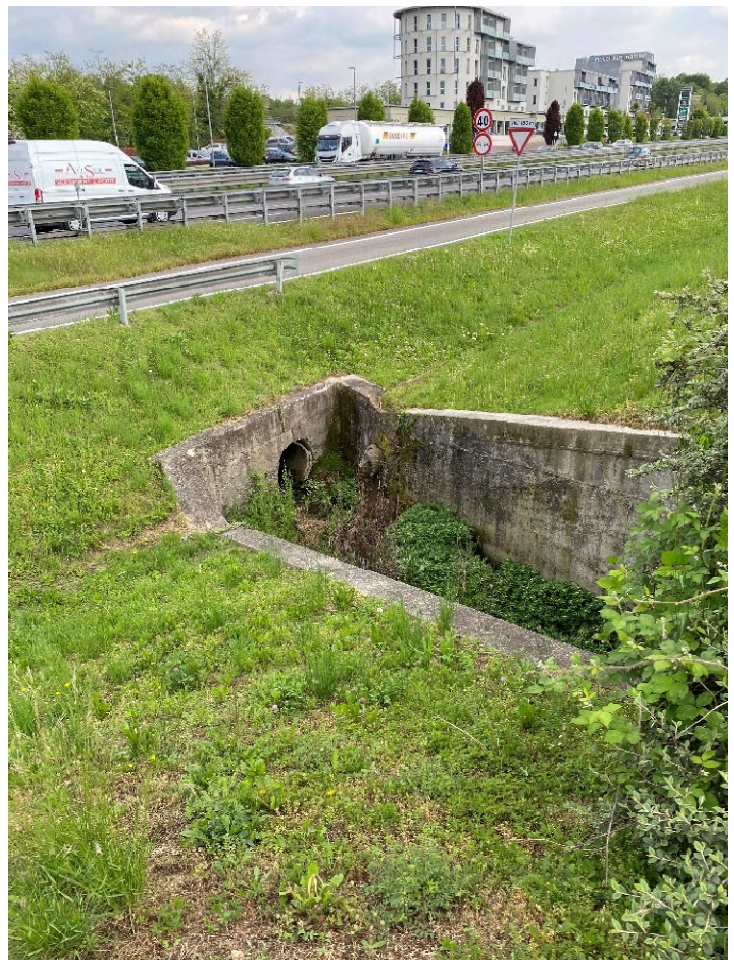
Foto 3.8 – 3.9 – Tratto 3: Vista imbocco (a sx) e uscita (a dx) sottopasso F.S. e S.S. 36 (Ø 800 mm)
