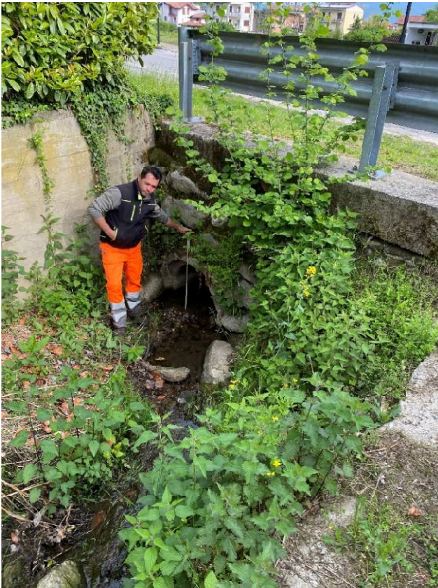
Foto 1.1 – 1.2 – Tratto 1: Vista imbocco (a sx) e uscita (a dx) sottopasso S.P. 69 (Ø 800 mm)
