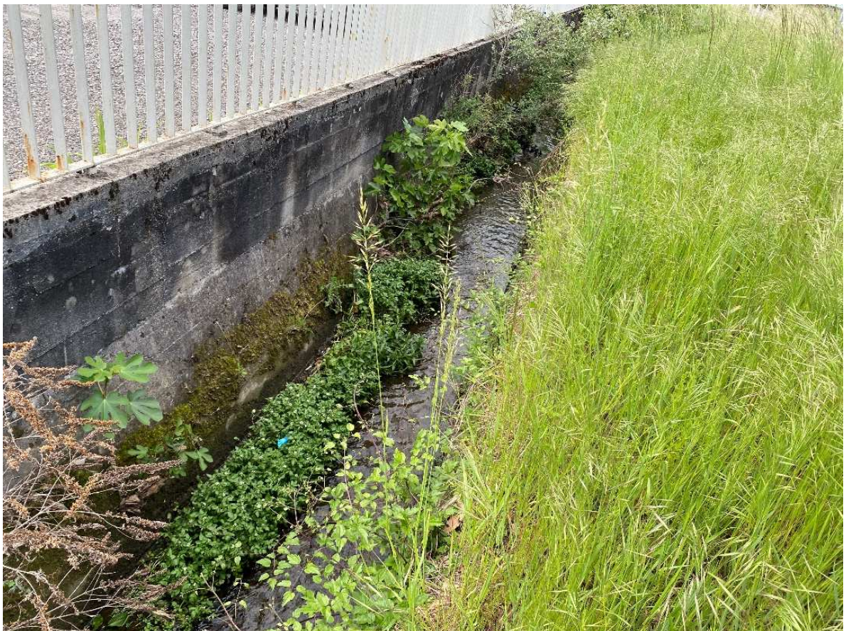
Foto 2.17 – 2.18 – Tratto 2: Vista uscita sottopasso S.S. 36 dopo confluenza tratto 2G (1,80 x 1,45 m)
