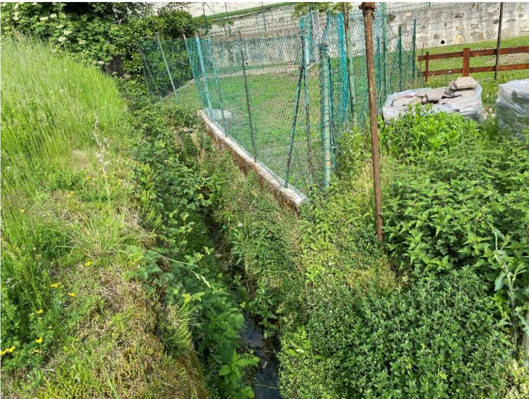
Foto 1.3 – Tratto 1: Vista alveo a monte di Via Prina (da valle)
