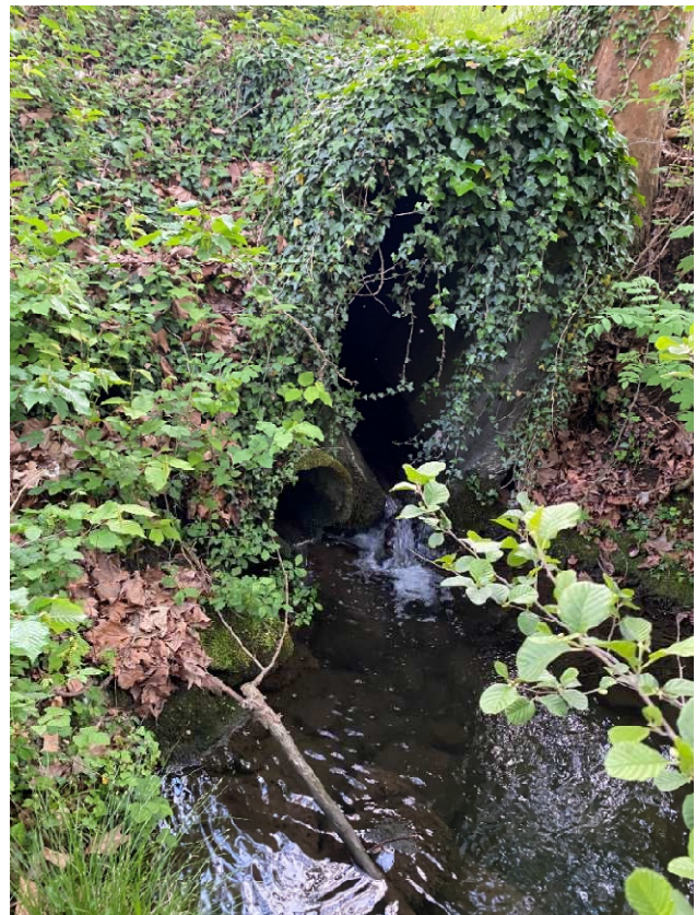
Foto 2.4 – 2.5 – Tratto 2: Vista imbocco (a sx) e uscita (a dx) sottopasso Via Italia (1,60 x 1,40 m)
