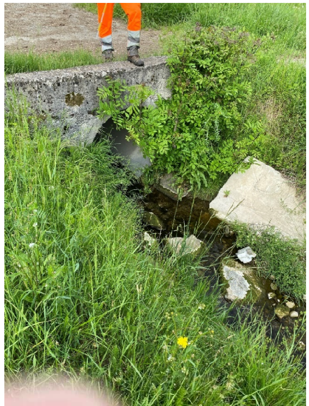
Foto 1.9 – 1.10 – Tratto 1: Vista attraversamento tra Via Pradonici e confluenza in T. Bevera (Ø 1000 mm)
