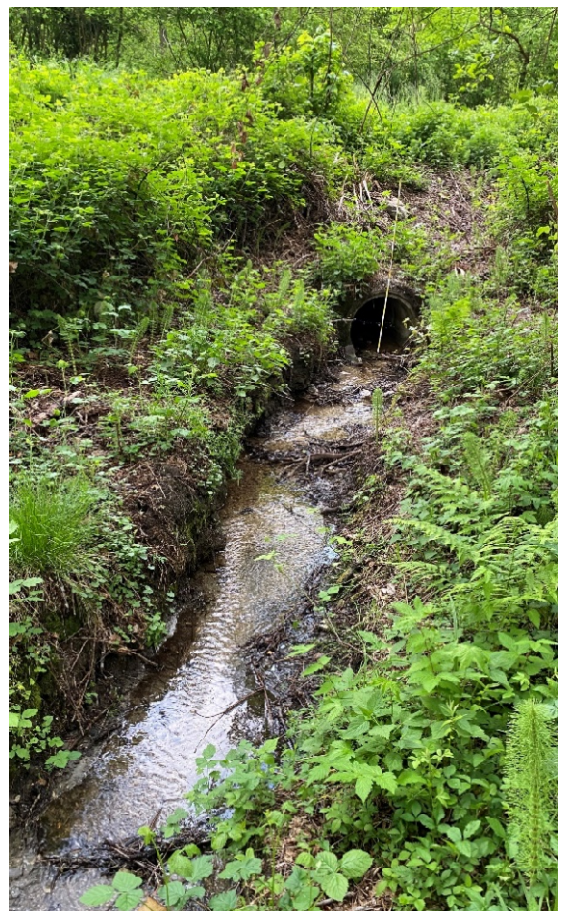
Foto 2A.2 – 2A.3 – Tratto 2A: Vista imbocco (a sx) e uscita (a dx) sottopasso Via Milano (Ø 800 mm)
