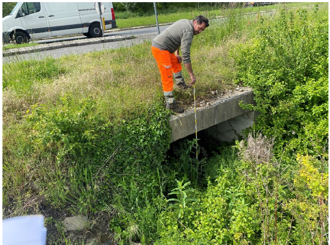
Foto 5.5 – 5.6 – Tratto 5: Vista alveo a monte sottopasso Via Provinciale e imbocco sottopasso Via Provinciale (2,0 x 1,0 m)
