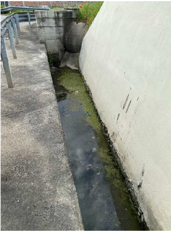
Foto 2.14 – 2.15 – Tratto 2: Vista canale di drenaggio sottopasso stradale S.S. 36 collegato con \varnothing 1500 mm
