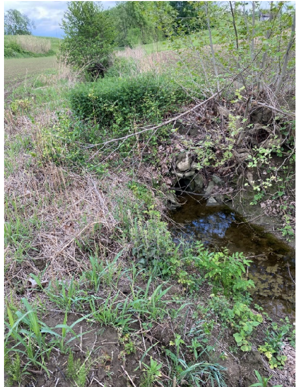
Foto 3.5 – 3.6 – Tratto 3: Vista alveo a valle Via Tregiorgio e sottopasso agricolo ( \varnothing 400 mm)
