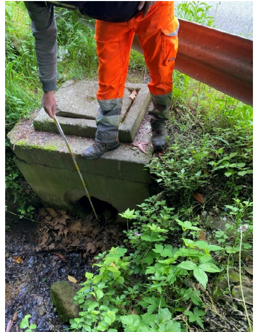
Foto 1A.1 – 1A.2 – Tratto 1A: Fosso stradale in località Ruscolo e imbocco sottopasso S.P. 69 (Ø 400 mm)
